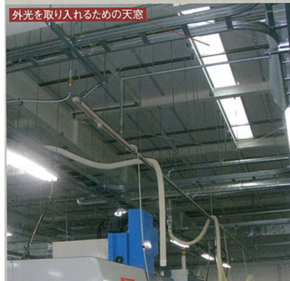
図C●天窓からの採光 同じく機械加工室。頂側窓からの光が届かない中央部には、天窓を設けた。照明は最小限で済む。
