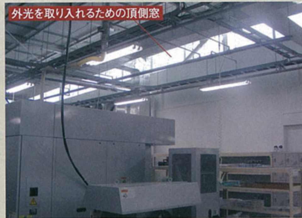
図B●頂側窓からの採光 機械加工を行う「機械加工室」。光学加工室ほどではないが、頂側窓から外光を取り込んでいる。
