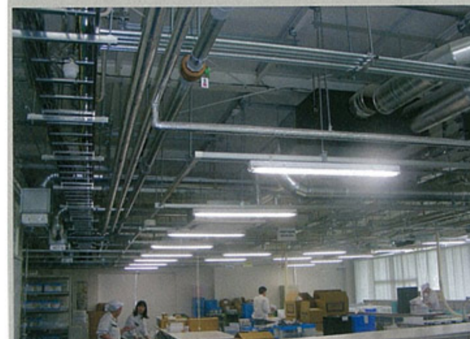
図E●むき出しの照明器具や配管 普通は隠す照明器具や配管を、あえて見せている。特に照明器具はきっちり等間隔に並ぶ。
