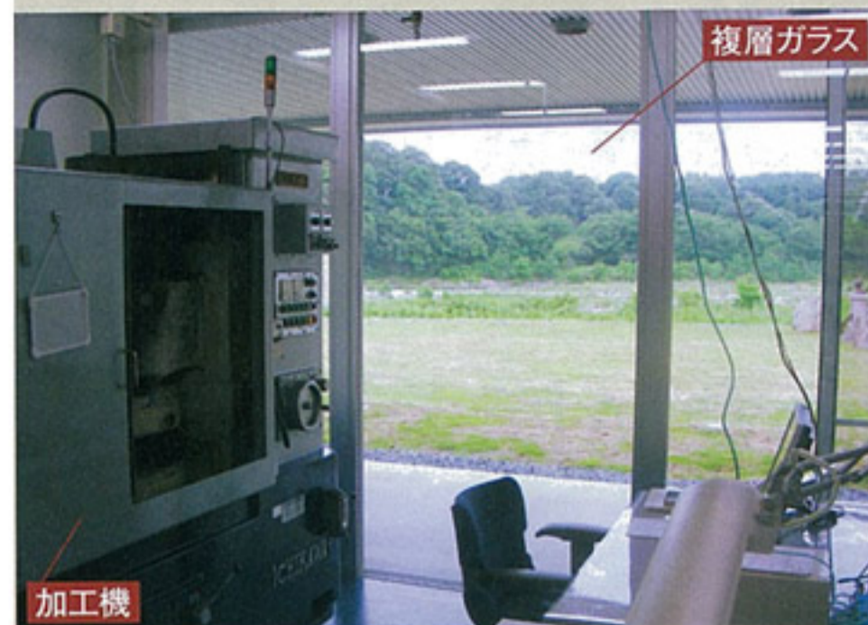
図A●側面からの採光 光学部品の加工を行う「光学加工室」。側面から外光を取り込む。複層ガラスにすることで断熱も徹底した。
