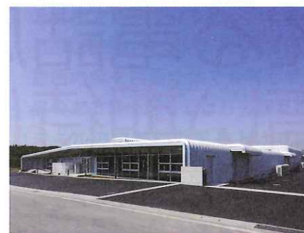
今年4月に稼働開始した深谷工場。
